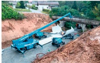
Bau einer neuen Wellstahlrohrbrücke im Ortsteil Waldeck
