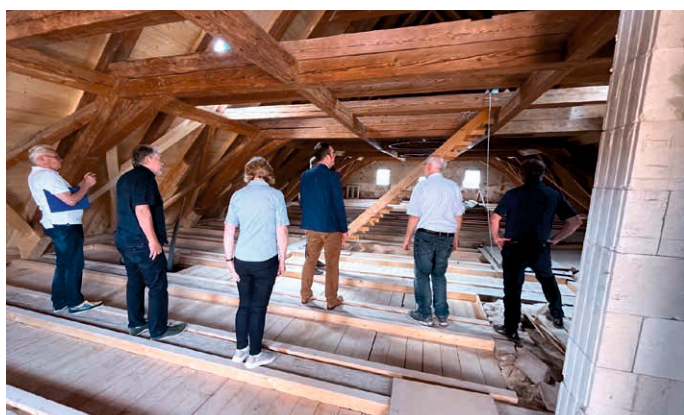
Interessiert betrachteten die Mitglieder des Schlichtvereins den Fortschritt des Ausbaus am Dachgeschoss.
