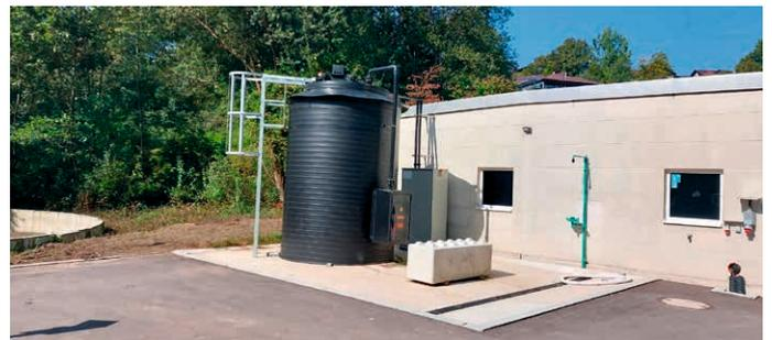
*Hier ist die Fällmittelstation zu sehen. Sie hilft die Gewässerbelastung deutlich zu reduzieren.*
