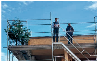
Auf der Baustelle des „Hauses für Kinder“ konnte Richtfest gefeiert werden
