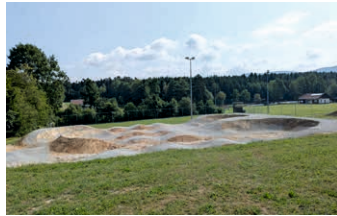
Der neue Pumptrack beim Sportplatz ist fast fertig
