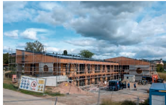
Die großen Bauprojekte im Ort sind schon weit fortgeschritten
