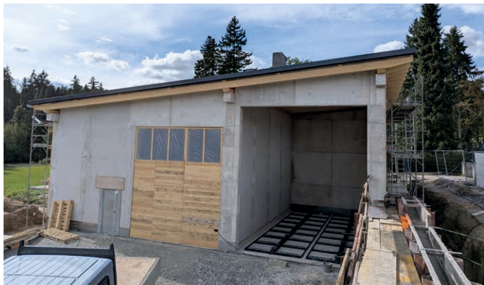
Die Baustelle des Heizwerks.
