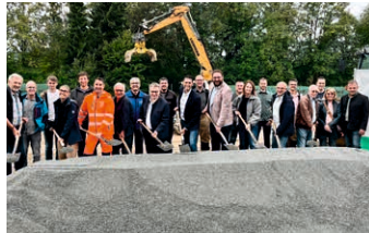
Auf der Baustelle im Freibad fand der offizielle Spatenstich statt
