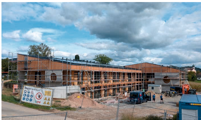
Die Baustelle der neuen Kindertagesstätte.
