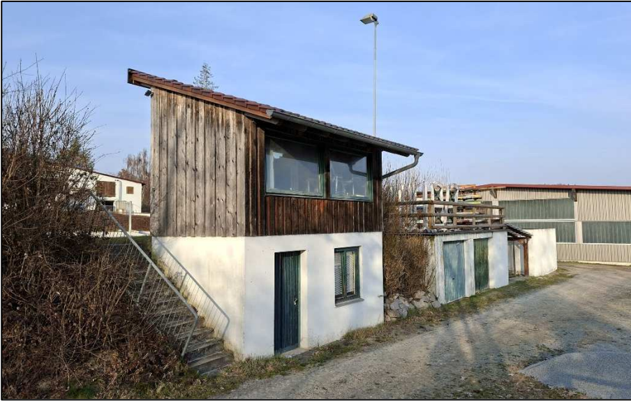
Lager- und Nebengebäude südöstlich Sandreitplatz
