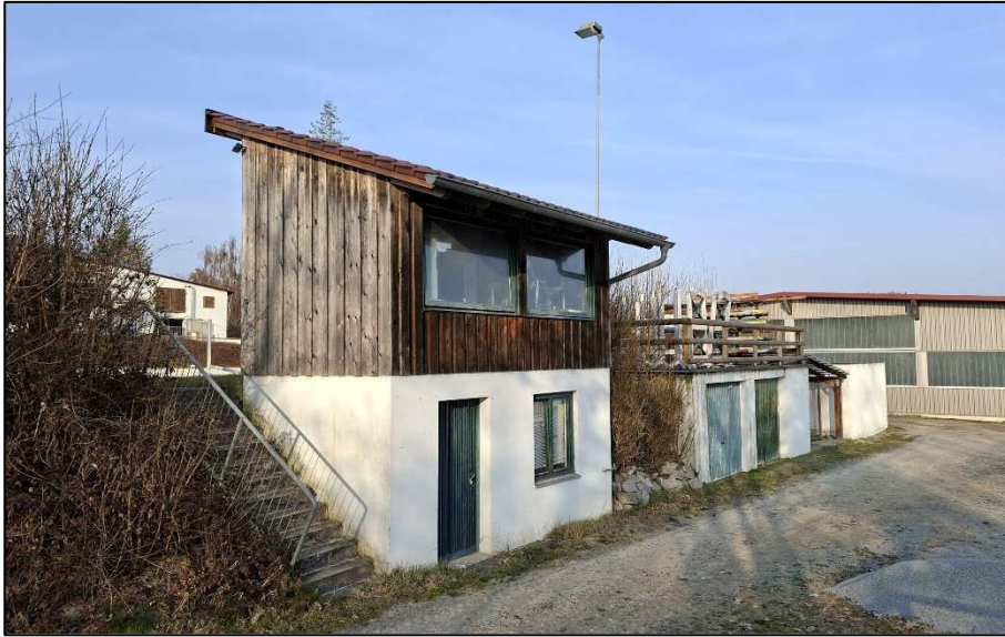
Lager- und Nebengebäude südöstlich Sandreitplatz
